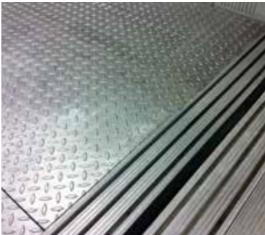
Detalle del suelo estriado
